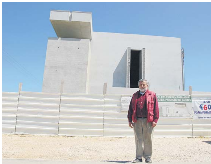
Eduardo Silva junto da obra da futura igreja para a qual se mobilizou grande parte da população das Gaeiras
